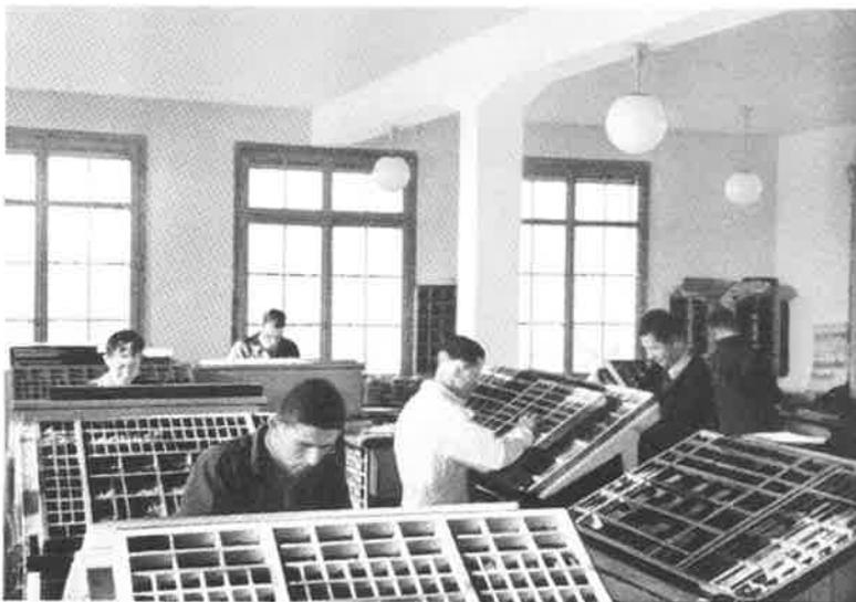
Während den ersten 30 Jahren seines Bestehens wurde der «Anzeiger für den Amtsbezirk Thun» noch weitgehend von Hand gesetzt. Nach und nach wurden die Handsetzer, namentlich was den Mengensatz anbelangt, von den viel leistungsfähigeren Setzmaschinen zurückgedrängt.
